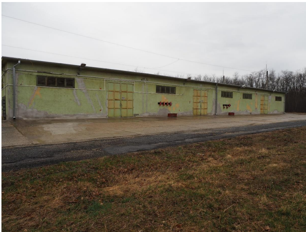
10. számú ábra: Az ábrán nyílófalazattal épült lőszerraktár a hozzá tartozó hálós villámvédelemmel látható. (A szerző saját felvétele)
