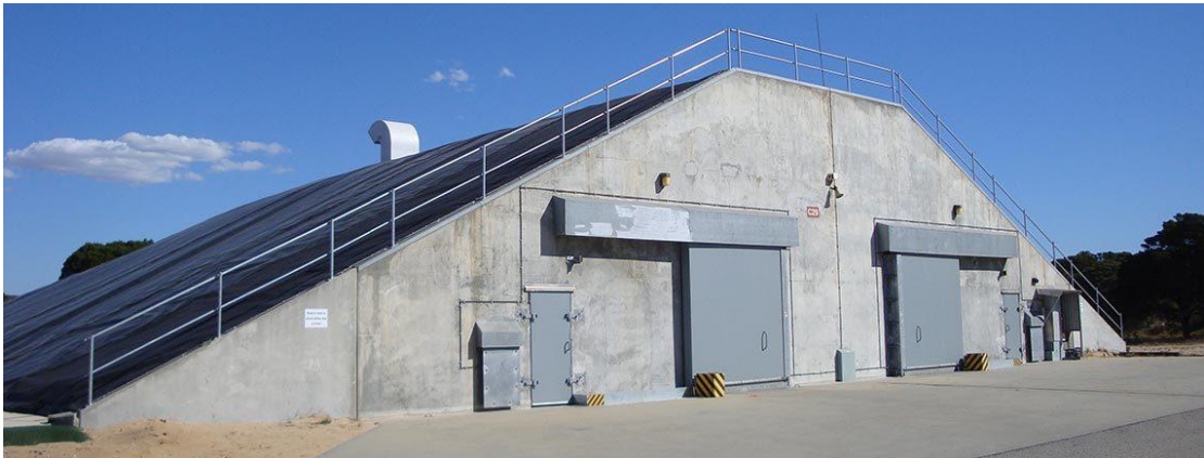
23. ábra: A Spantech legnépszerűbb védelmi épülete a Spantech Explosives Storehouse (ESH), egy földdel borított épület, amelyet kifejezetten a védelmi erők által használt összes robbanóanyag (EO) tárolására terveztek. 51
