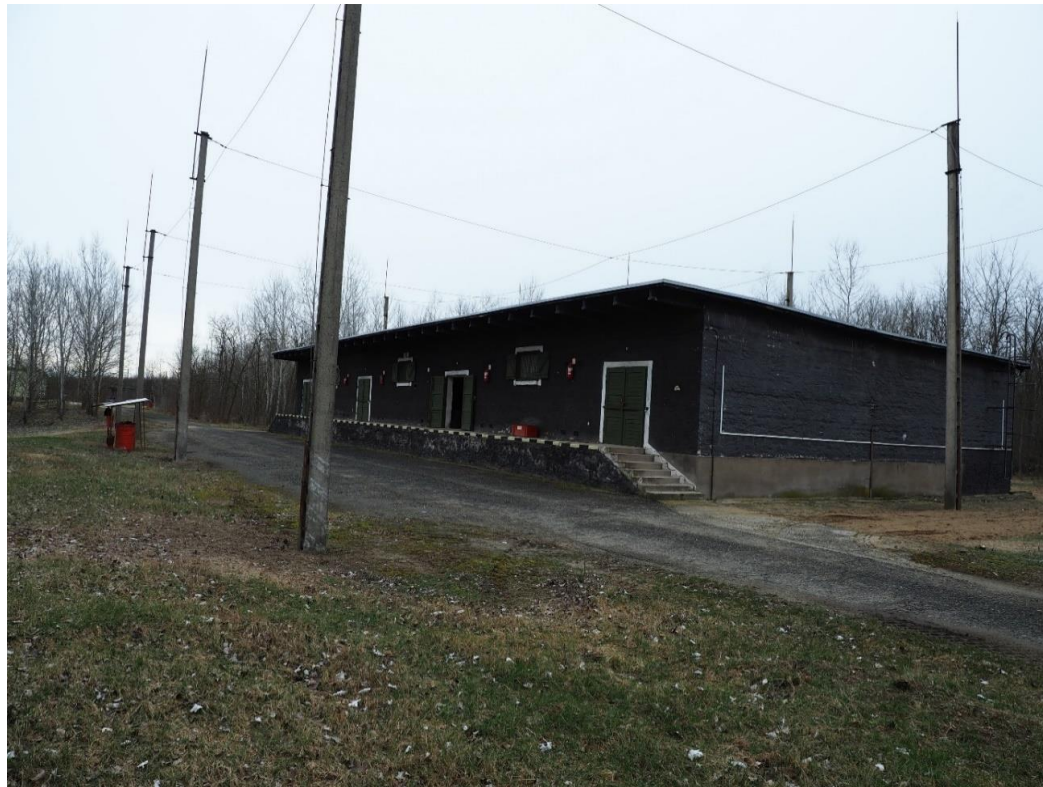
9. számú ábra: Repülőtetővel és villámvédelemmel kialakított lőszerraktár (A szerző saját felvétele)
