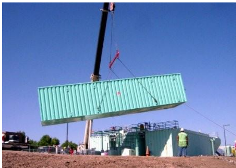
2.10. ábra: A konténerizált szennyvíztisztító mobilizálhatósága [95]
