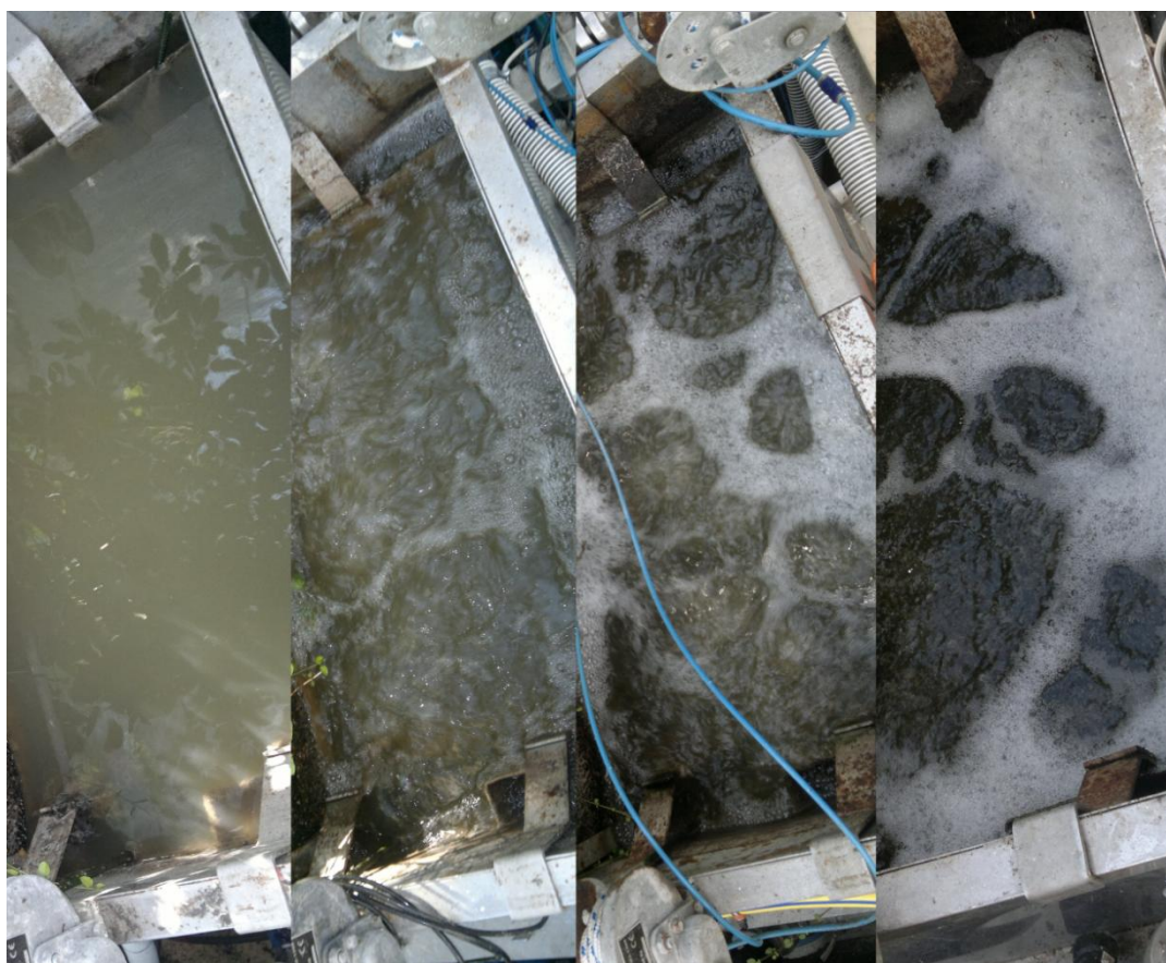
2.3. ábra: Buborékképződés egy elődenitrifikáló (1 anoxikus, 3 aerob) reaktorkaszád 16 mentén (saját fotók [71] alapján)
