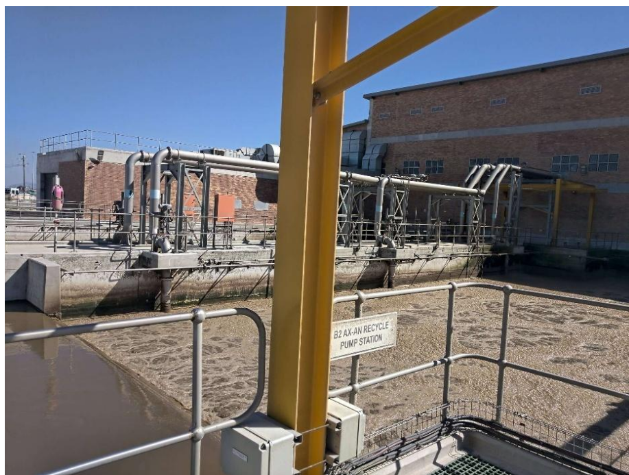
1.1. ábra: Levegőztetés nélküli és levegőztetett reaktorok a dél-afrikai Zandvliet szennyvíztisztító telepen (saját fotó)
