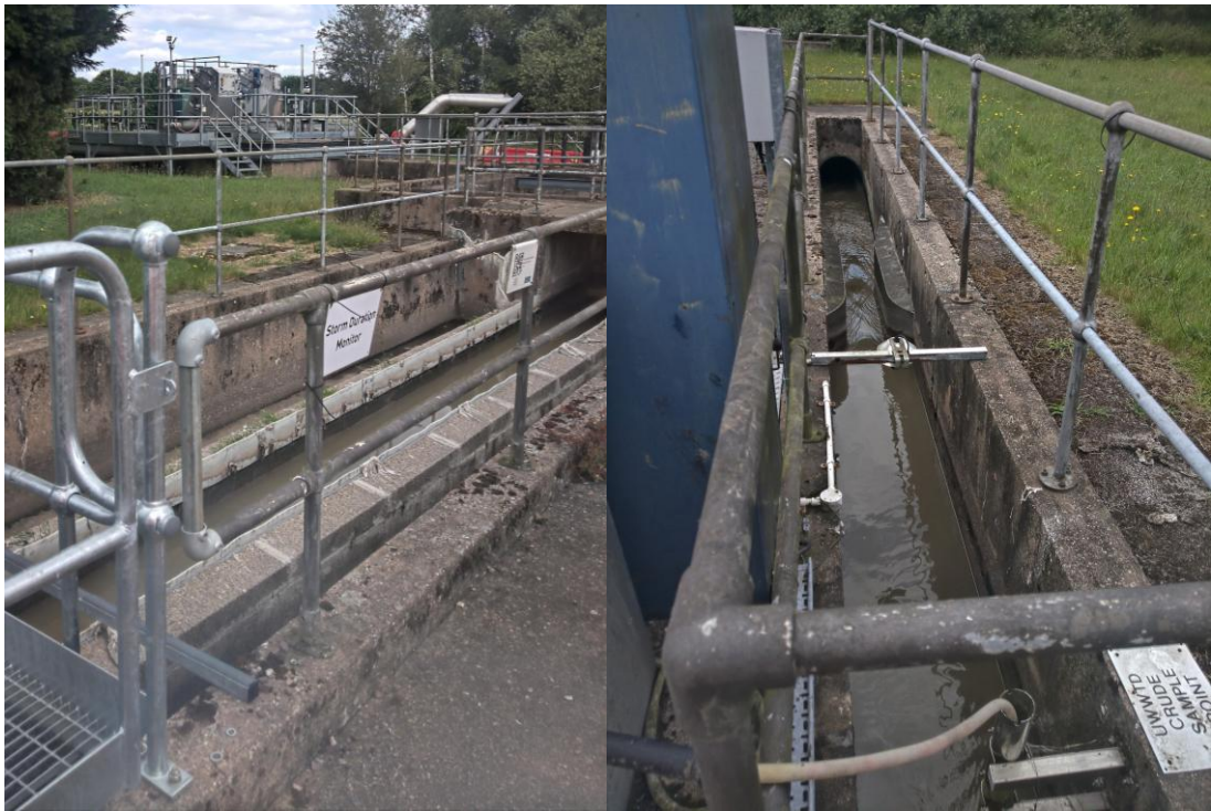
5.1. ábra: Az angliai Walsall Wood szennyvíztisztító telep csapadékesemény-időtartammérője, Parshall-csatornával (saját fotók)
