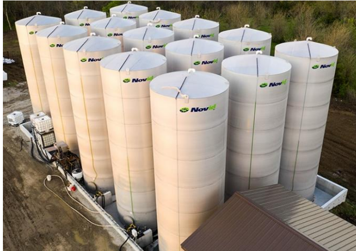
20. ábra: Példa az alacsony és a tartály palástjához közel eső felfogótér falra
