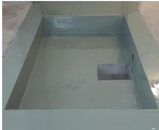
34. ábra: Példa beton süllyesztett kármentő medencére
