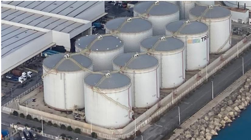
35. ábra: Példa vasbeton felszínre helyezett kármentő medence
