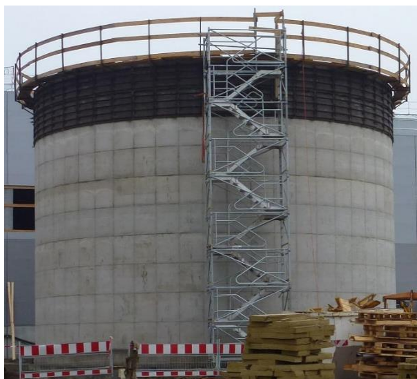
36. ábra: Csúszózsálas technológiával történő építés
