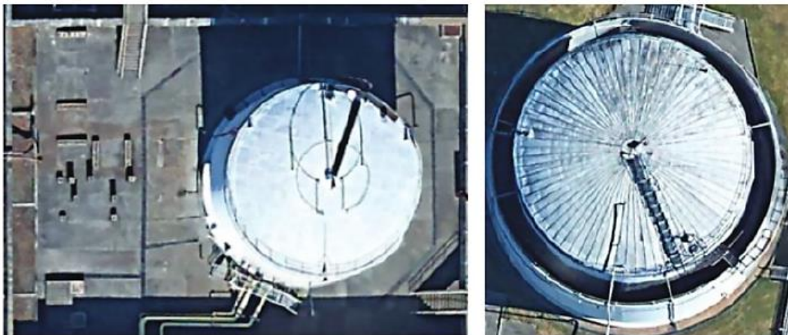
13. ábra: Az alkalmazott felfogótér két elterjedt típusa (bal: vasbeton kármentő medence, jobb: acéllemezes védőgyűrű)
