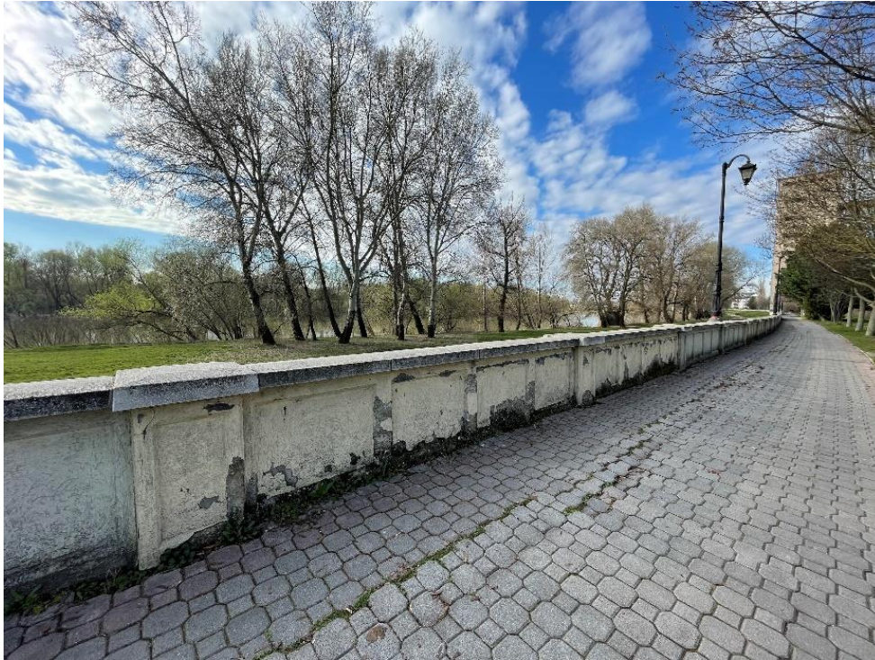
33. ábra Szolnoki árvízvédelmi parapetfal (készítette: a szerző)
