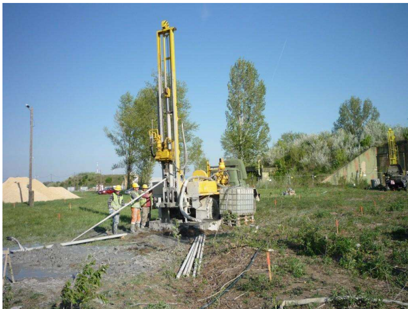
80. ábra Talajszondák elhelyezése Pápán [196]
