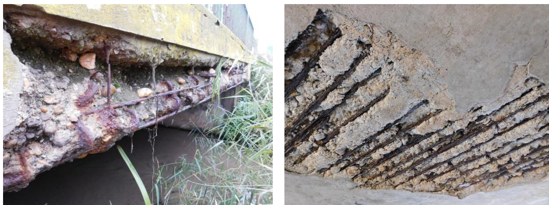
25. ábra: A legrosszabb állapotú híd a 34+982 km szelvényben 266
