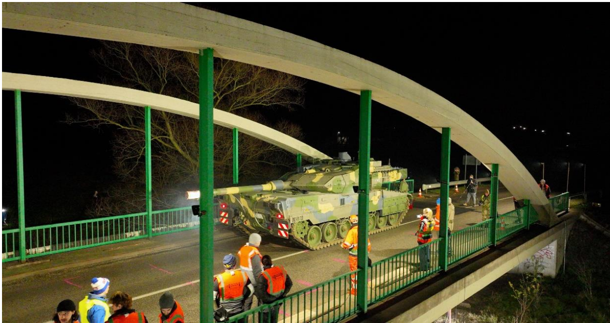
1. ábra: A kecskédi Által-ér-híd próbaterhelése Leopard 2A7HU harckocsival 2024. november 18-án 21
