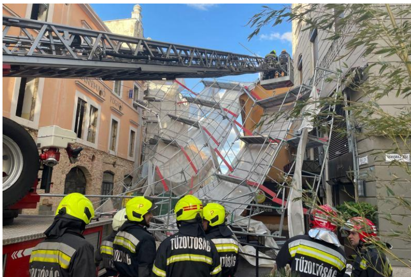
12. kép: Szélteher okozta állványösszeomlás [63]
