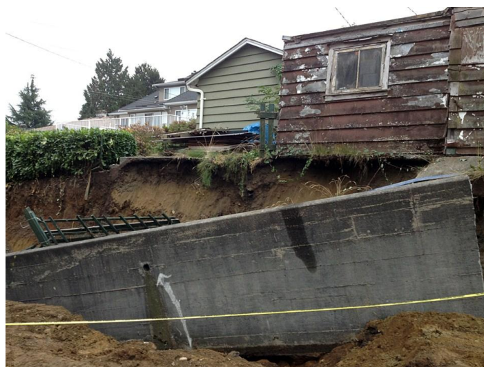
3. kép: Résvezető gerenda beomlása [42]
