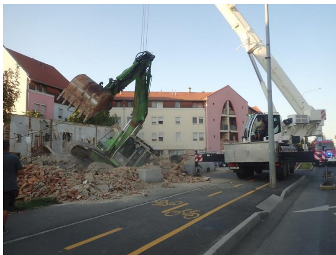
2. kép: A pincébe zuhant munkagép [40]
