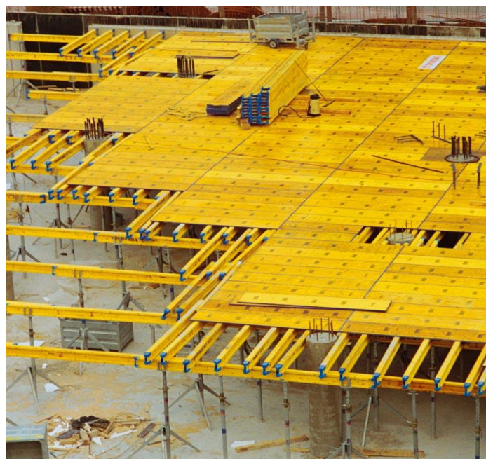
23. kép: Fatartós födémzsaluzat bezsaluzása [95]
