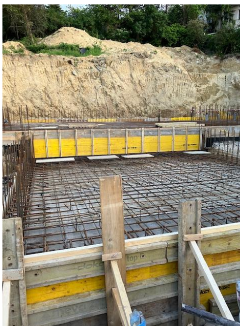
26. kép: Talpgerendával erősített alaplemez zsaluzása, készítette a szerző, forrás: saját munka.
