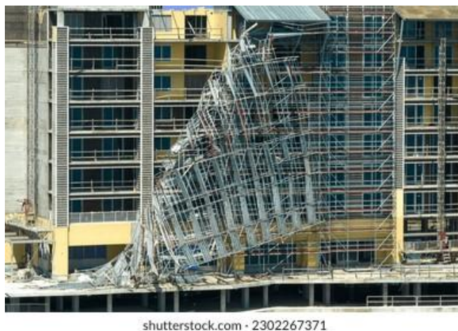
11. kép: Horgonyhiba miatti állványösszeomlás [62]
