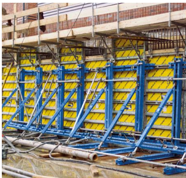
13. kép: Egyoldali falzsaluzat [72]
