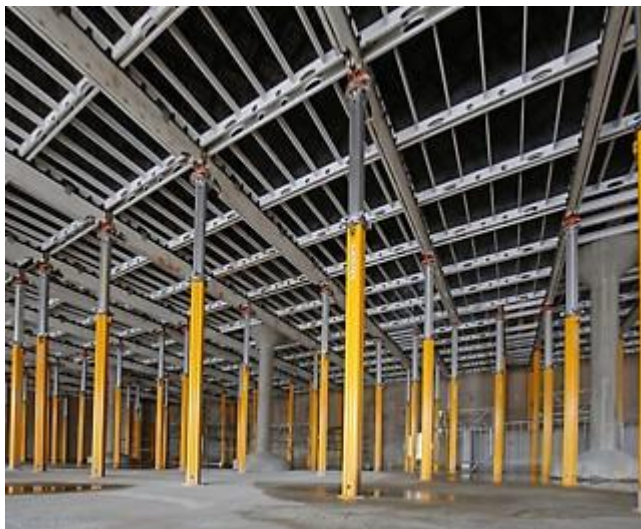
16. kép: Keretes födémzsalu rendszer [76]
