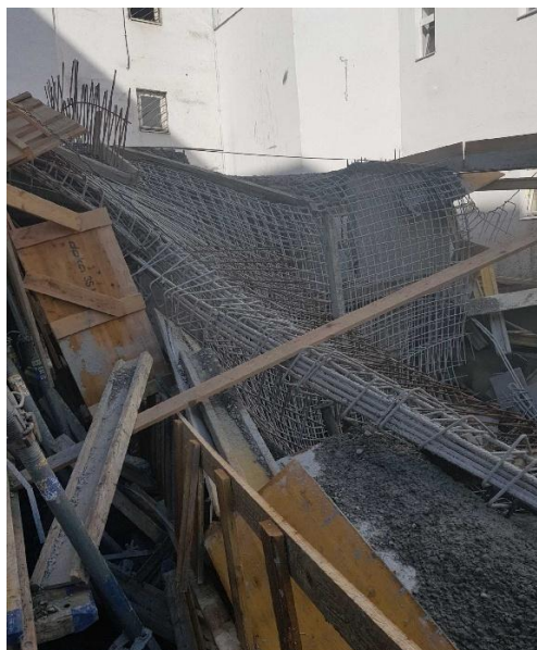
20. kép: Födémösszeomlás a XIII. kerületben, készítette a szerző, forrás: saját munka
