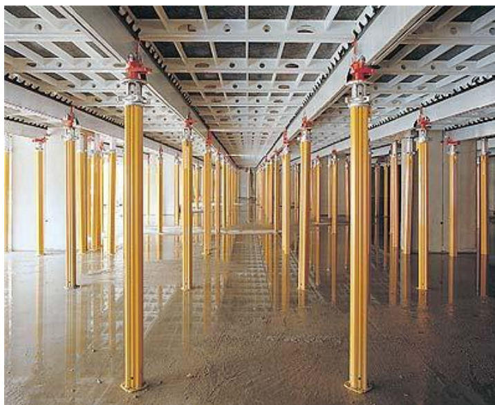
22. kép: Ejtőfejes födémzsaluzat [93]
