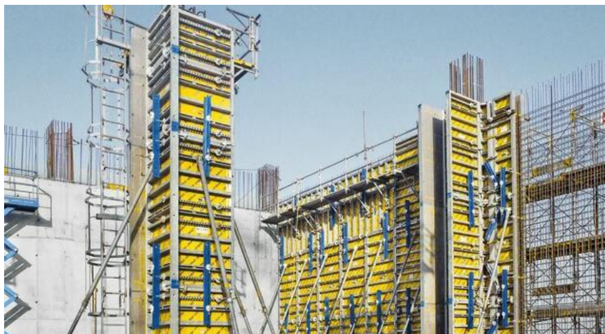
14. kép Pillér zsalu rendszerelemekből [73]
