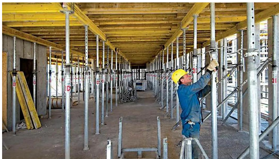
15. kép: Fatartós födémzsalu rendszer [75]
