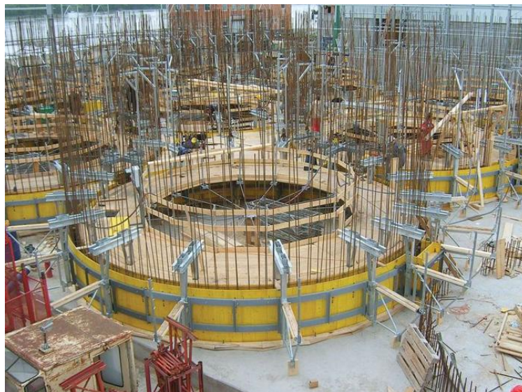
19. kép: Csúszó zsaluzati rendszer [85]
