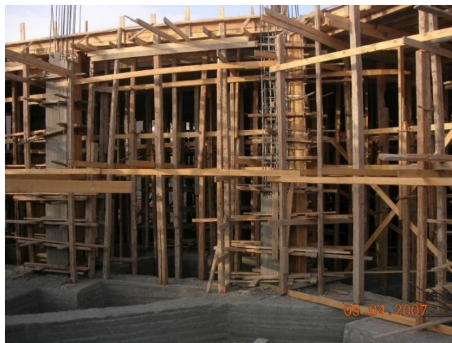
8. kép: Állványszerkezet fa ácsolatból. Saját forrás
