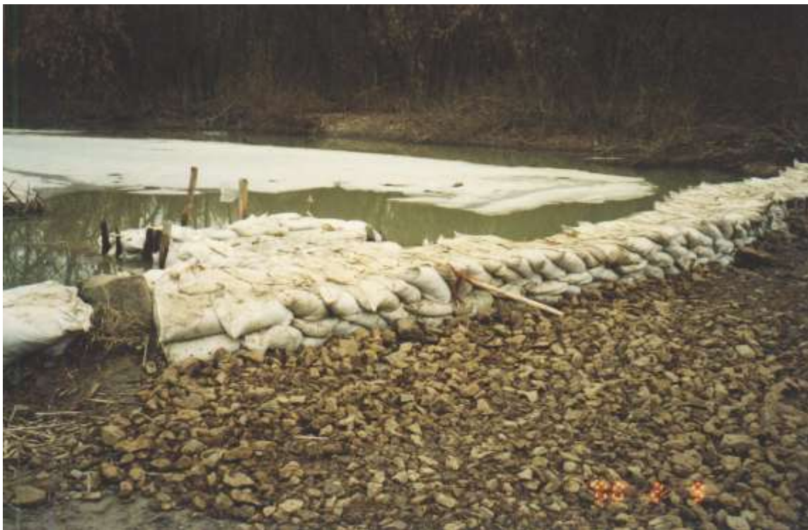
24. ábra Homokzsákokkal elzárt tározóbéli vízfolyás (forrás: KÖTIVIZIG )
