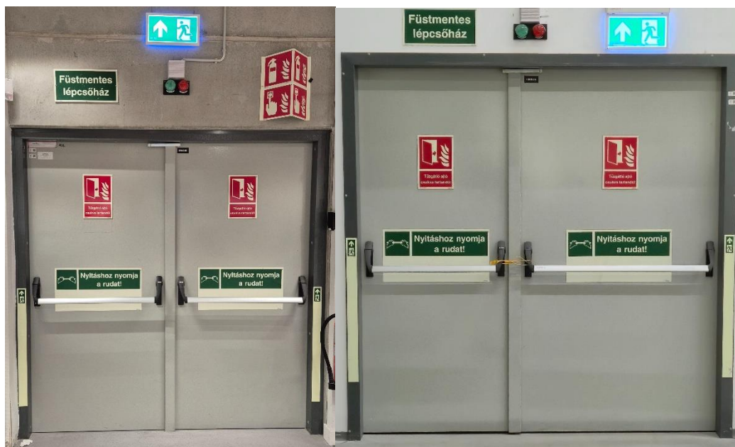
11. kép – Szimmetrikus és aszimmetrikus szárny kialakítású, szimmetrikusan elhelyezett pánikrúddal szerelt túlnyomásos füstmentes lépcsőházba ajtók, készítette a szerző
