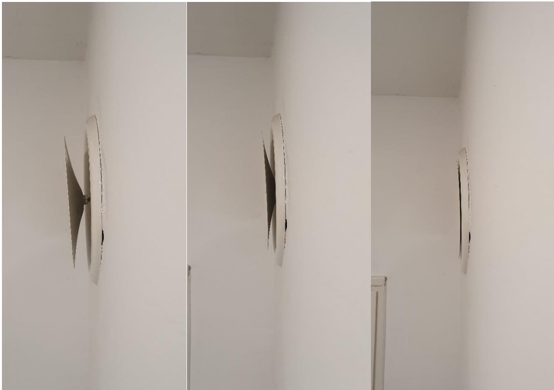
4. kép – A légszelep kézzel történő állításával az előtérbe bevezetett levegő mennyisége szabályozható, készítette a szerző
