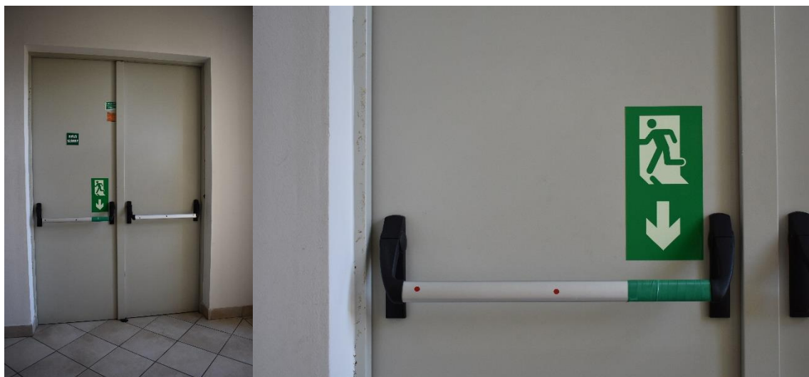
14. kép – túlnyomásos füstmentes lépcsőházba nyíló ajtó nyitást elősegítő jelölése, készítette a szerző
