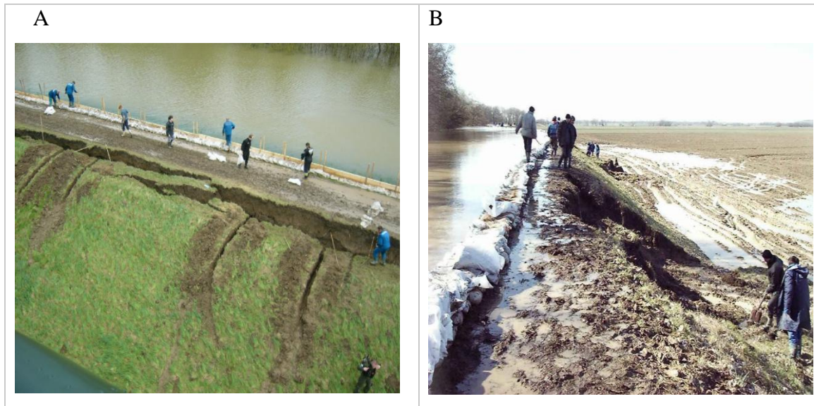
57. ábra A, Töltéscsúszás a Hármas-Körös jobb part 0+500 tkm szelvényben 2006; B, Tarpai rézsűcsúszás 2001 [6]
