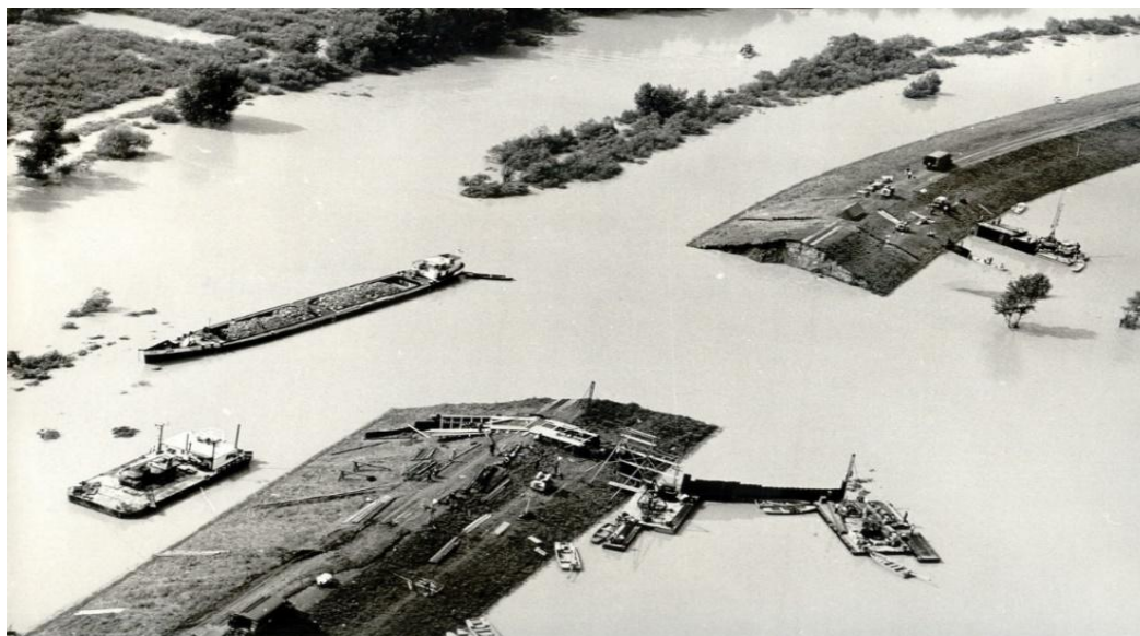
69. ábra Kettős-Körös jobboldali töltése 16+125 tkm szelvényben töltésszakadás (forrás: Körös-vidéki Vízügyi Igazgatóság) (készítette Vízzy Zsigmond)
