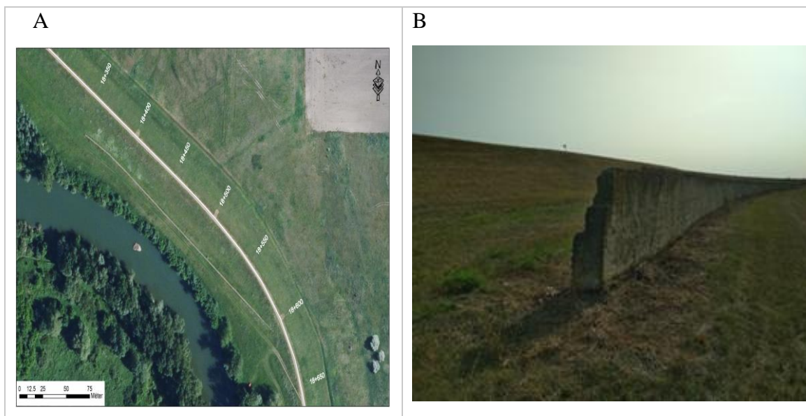
66. ábra Kettős-Körös jobb oldali árvízvédelmi töltése 18+350-18+600 tkm között feltárt tégla fal (készítette: a szerző)
