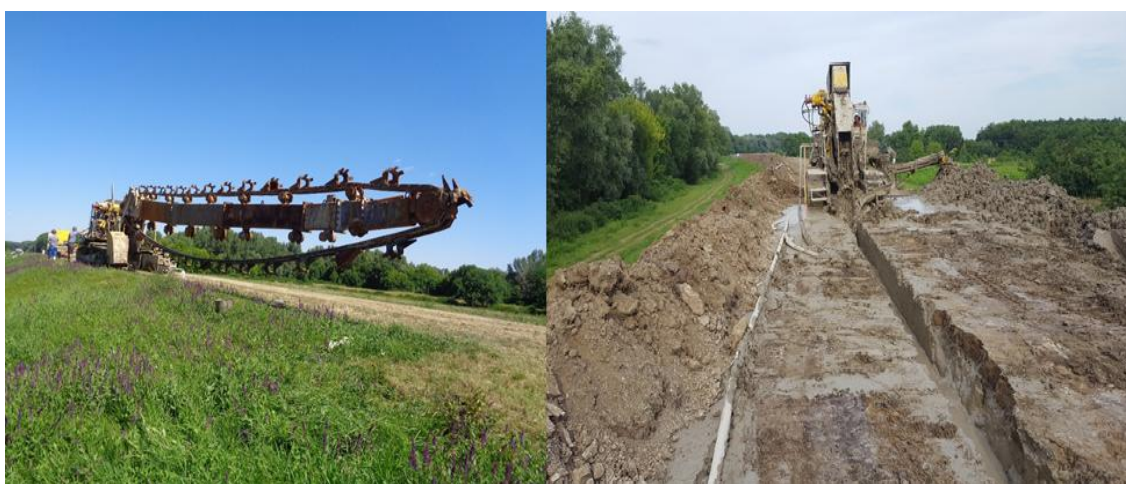
67. ábra Résfalépítés a Hármas-Körös töltésén (forrás: Körös-vidéki Vízügyi Igazgatóság) (készítette: a szerző)
