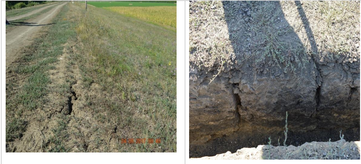
56. ábra Töltésrepedések (forrás: Körös-vidéki Vízügyi Igazgatóság) (készítette: a szerző)
