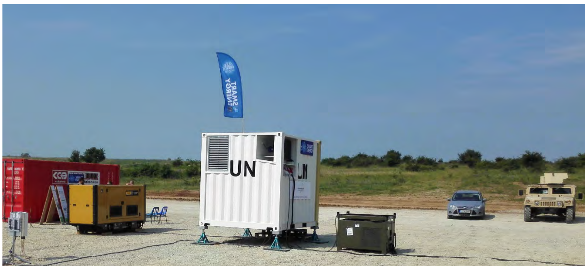
18. ábra: Előkészített tábori villamos hálózat részlete a CL15 nemzetközi logisztikai gyakorlaton Várpalotán (saját fotó). A konténertől balra található a sárga dízelaggregátor (jelen esetben egy civil típus), tőle jobbra a (zöld) villamos elosztó szekrény. Bal oldalt az előtérben látható az ún. „bálvány”, ahová a fogyasztókat lehet csatlakoztatni
